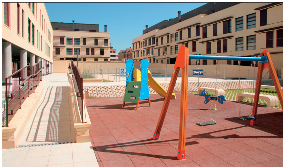
En la imagen, los nuevos pisos de El Montecillo
